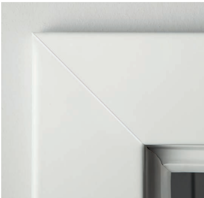
01 ZARGE WEISSLACK-OBERFLÄCHE (SPRITZLACK) MIT V-FUGE
